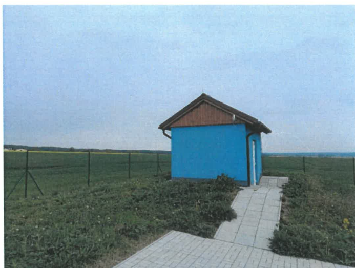
Obrázek č. 6: Objekt vodojemu
