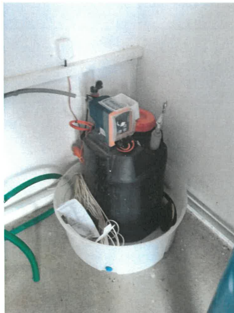
Obrázek č. 2: Zařízení pro aplikování chlornanu sodného ( \text{NaClO} ) pro ošetření vody
