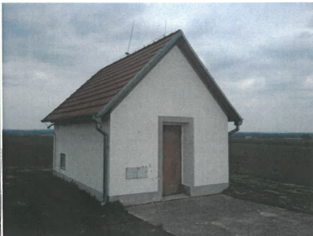
Obrázek č. 5: Objekt vrtu
